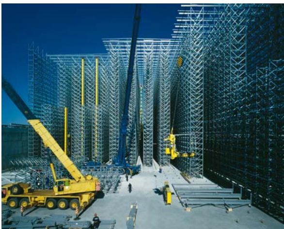
Abbildung 1: Hochregallager in Silobauweise
